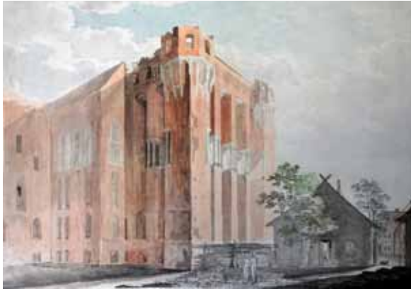
Abb. 3 Ansicht des Hochmeisterpalastes von Nordwesten (Aquarell Friedrich Gilly 1794/95). Am unteren Bildrand (Mitte) erkennt man David und Friedrich Gilly in Rückenansicht.
