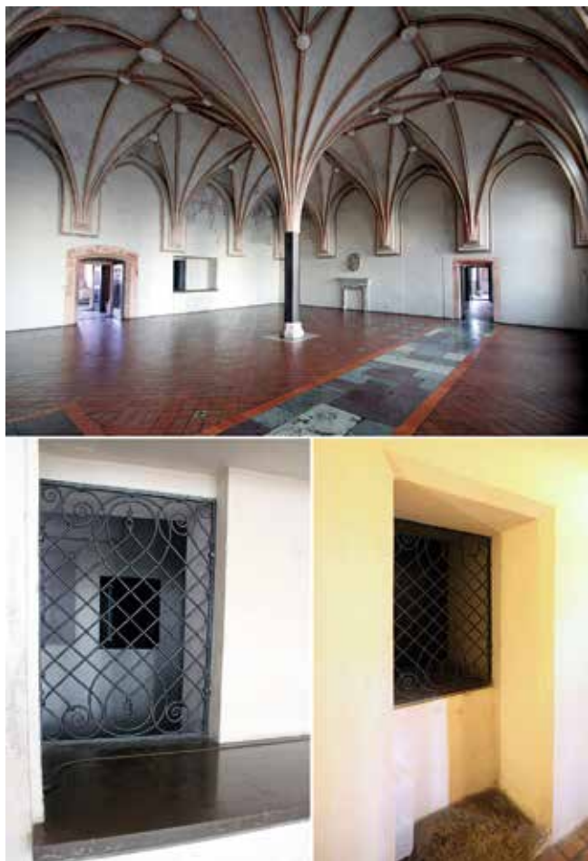
Abb. 5 Oben: Innenansicht des Winterremters Richtung Nordosten. Unten: Schenkbank des Winterremters, Ansicht vom Innenraum (links) und vom Dienergang (rechts). Fotos C. Herrmann.
